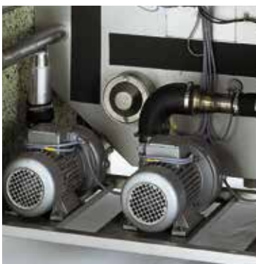
To-pumpe-system og sentrifugering sparer energi, vann, granulater, såpe og skyllemiddel.
